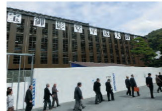
知恩院 御影堂平成大修理
